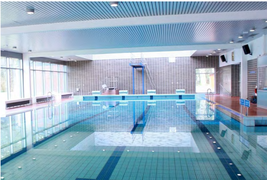
Foto: Das Wardenburger Hallenbad vor der Sanierung
