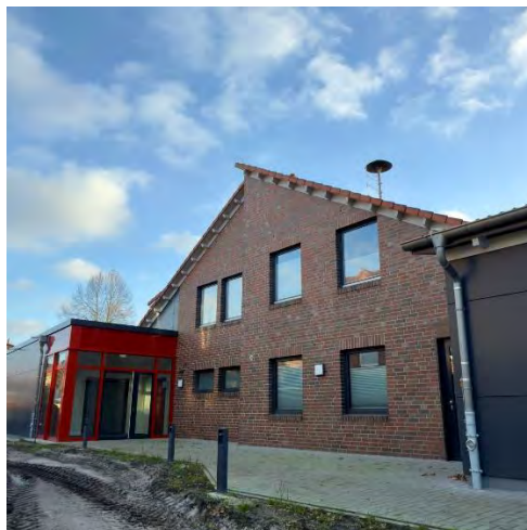
Neubau hinterer Bereich
