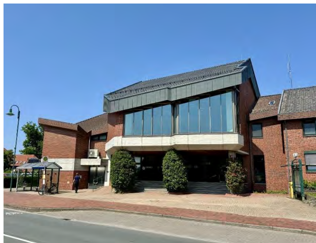
Die neue Fensterfront des neugestalteten Ratssaales
