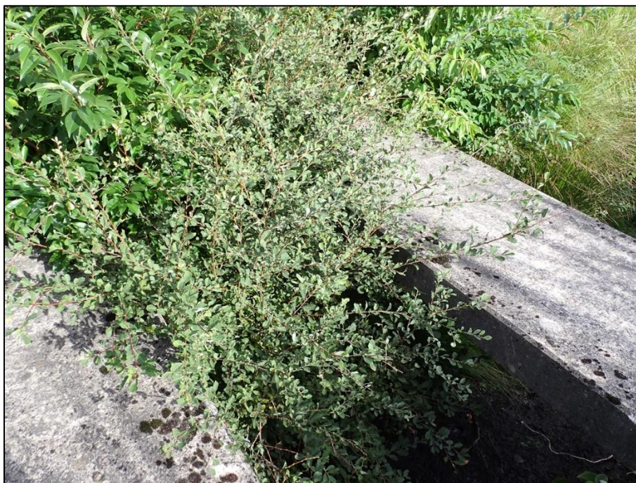
Abbildung 3: Querung des Östlichen Vorfluters mit einer zweispurigen Betonbrücke
