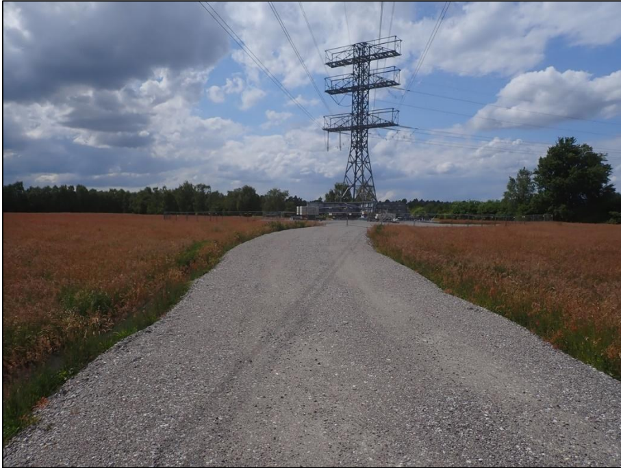
Abbildung 10: Baustraße (OX) zu einem Hochspannungsmast innerhalb einer Grünlandfläche
