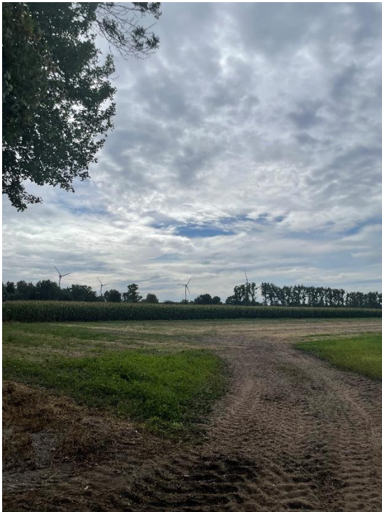
Abbildung 18: Blick auf den Windpark Rote Erde.
