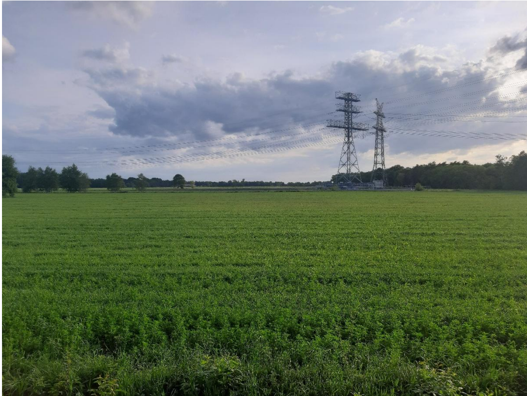
Abb. 7: Südöstlicher Bereich des UG mit z.T. neu gebauten Stromtrassen
