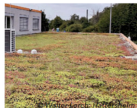
bzw. Tragfähigkeit des Dachs nicht zu gefährden. Walter Lerch Bau- und Industriebedarf GmbH & Co. KG, Hattersheim, Neubau 2010
