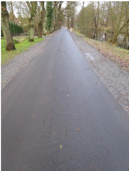
Technisch gesehen wäre alternativ ein Komplettausbau mit neuem Unterbau in diesem Abschnitt auch nur mit erheblichem Aufwand und Kosten möglich, da der Wasserdruck vom Querkanal mit Grundwasser-senkungen und entsprechendem Spundwandverbau abgefangen werden müsste.
